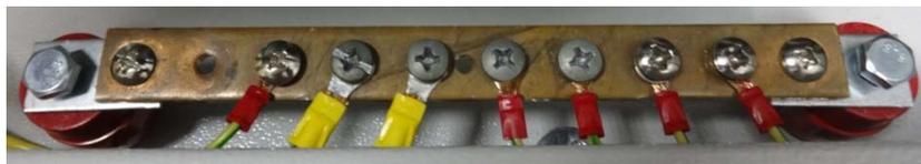
**Рисунок 7 – Шина заземления**
